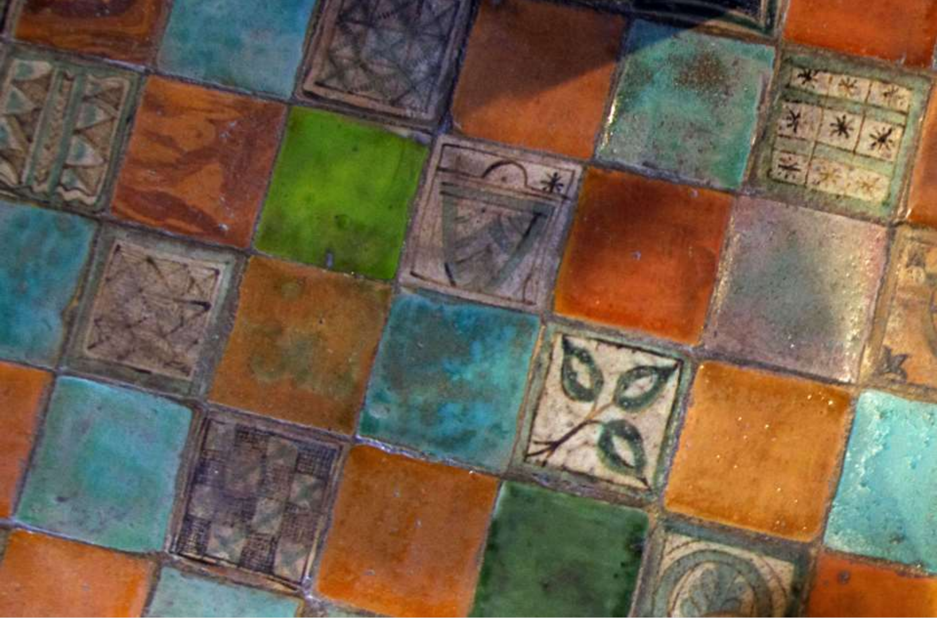
Pavements actuels d'une salle du palais (restauration)
