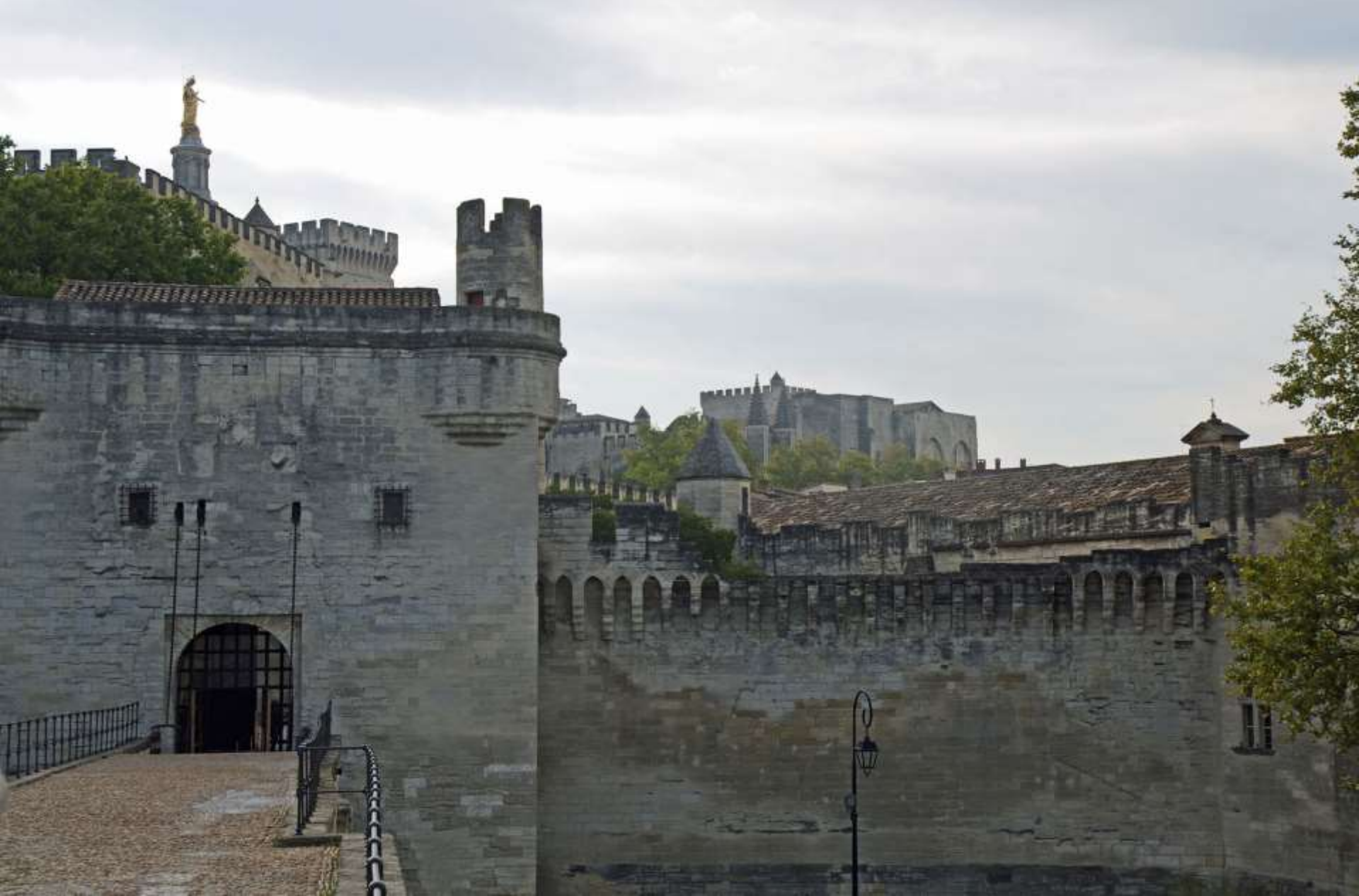
Notre-Dame des doms et le palais, vus du pont
