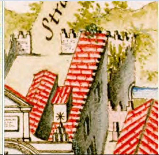
Dettaglio della struttura fortificata della Porta.
